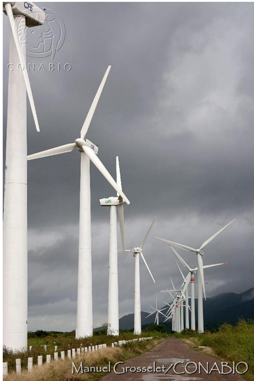
Fig. 4.22 En algunas regiones de nuestro país es posible aprovechar las condiciones naturales que se presentan. Por ejemplo, en lugares donde las corrientes de aire son fuertes, se han instalado aerogeneradores para aprovechar la energía eólica.
