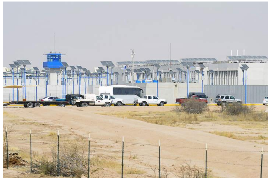
Fig. 4.25 Centro Federal de Readaptación Social no. 14. Fotografía del El Siglo de Torreón.
